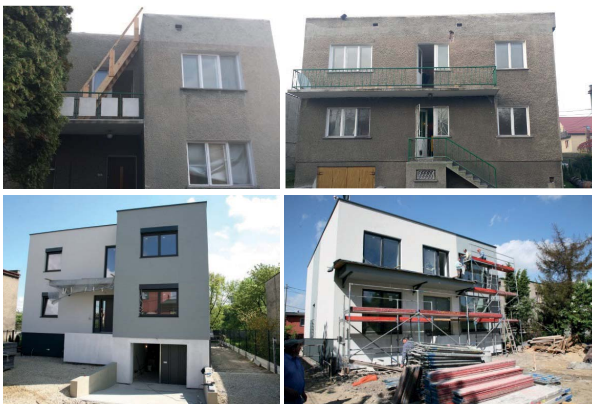
Ryc. 4. Remont jednorodzinny budynek mieszkalny w Siemianowicach Śląskich” Firma „KAMIŃSKI Zaopatrzenie Przemysłu, Robert Kamiński”
