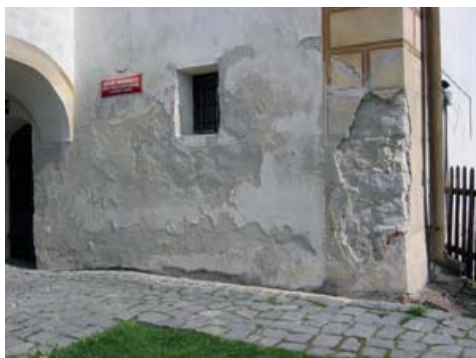
Rys. 7. Destrakcyjne działanie wody i soli
