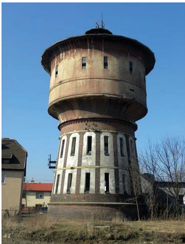
Rys. 3. Wieża ciśnień, kwiecień 2013. Fot.: Ł. Wądryński
