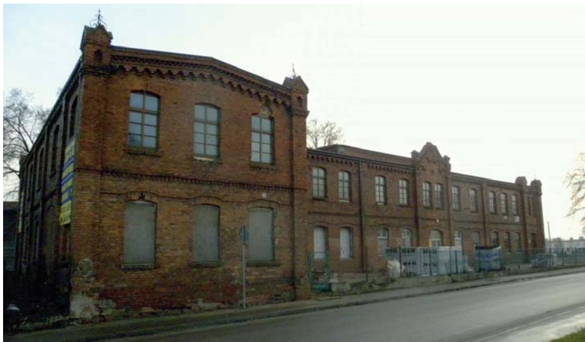
Rys. 4. Budynek dawnej szkoły, grudzień 2013. Fot.: Ł. Wądryński
