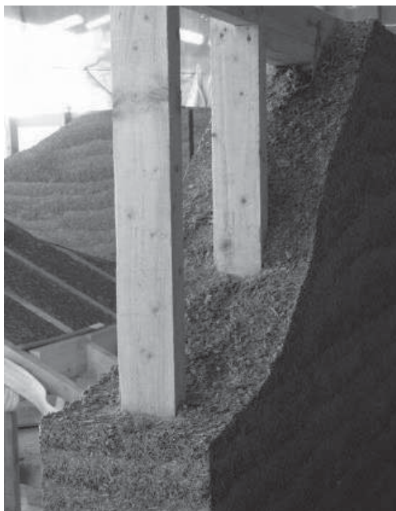
Rysunek 1. Wypełnienie konstrukcji szkieletowej materiałem kompozytowym opartym na konopi [Bevan i Woolley 2010]
