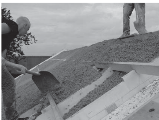
Rysunek 7. Izolacja dachu kompozytem na bazie konopi [www.hempcrete.co.uk]
