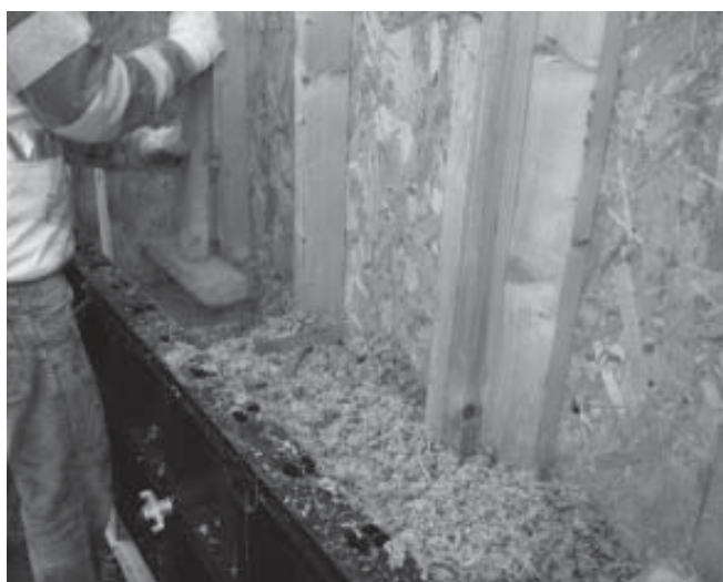
Rysunek 2. Układanie i zagęszczanie kompozytu w szalunku ściennym [Bevan i Woolley 2010]
