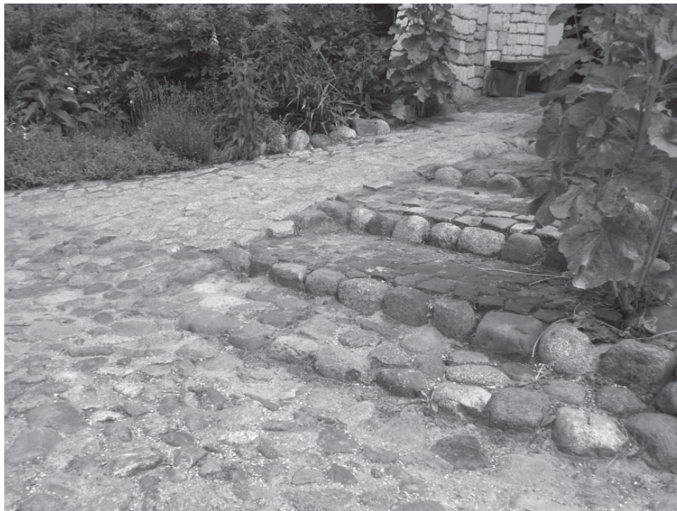
Fotografia 4. Nawierzchnia ogrodowa wykonana z kamieni polnych
