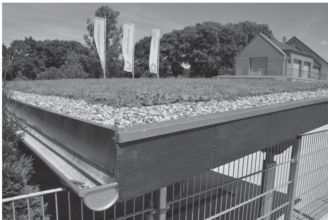
Fotografia 4. Ekstensywny Dach Zielony
