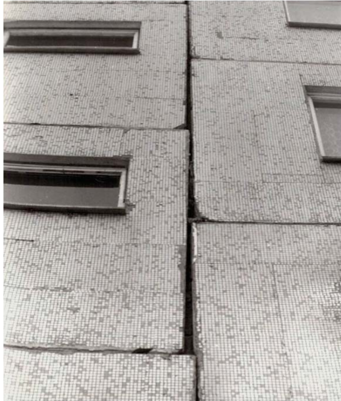
Rys. 10. Wady w złączach elementów ściennych ( www.thelinked.nspace.pl )
