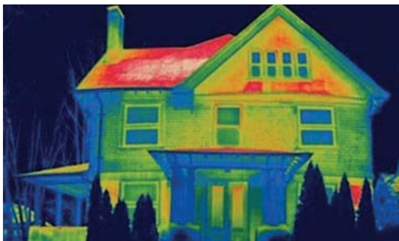
Rys. 2. Termogram budynku mieszkalnego z obszarami wyraźnego ubytku ciepła ( www.izolacje.com.pl )
