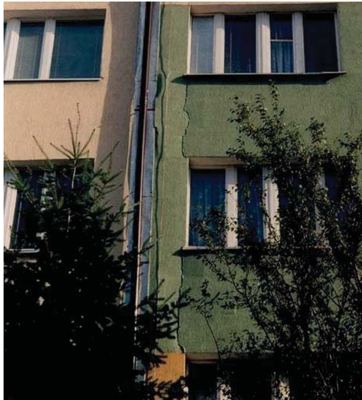
Rys. 7. Nowo docieplony budynek kwalifikujący się do ponownego remontu ( www.thelinked.nspace.pl )
