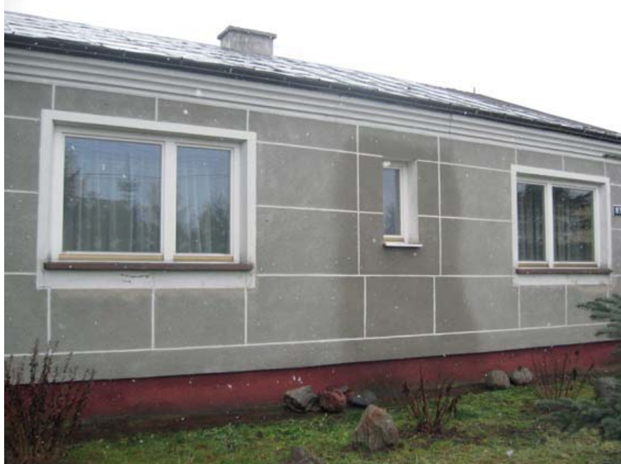
Rys. 1. Zdjęcie budynku przed rozbudową (Projekt budowlany rozbudowy budynku mieszkalnego jednorodzinnego wykonany przez pracownię inżynierską Bartosz Marek Zegardło)
