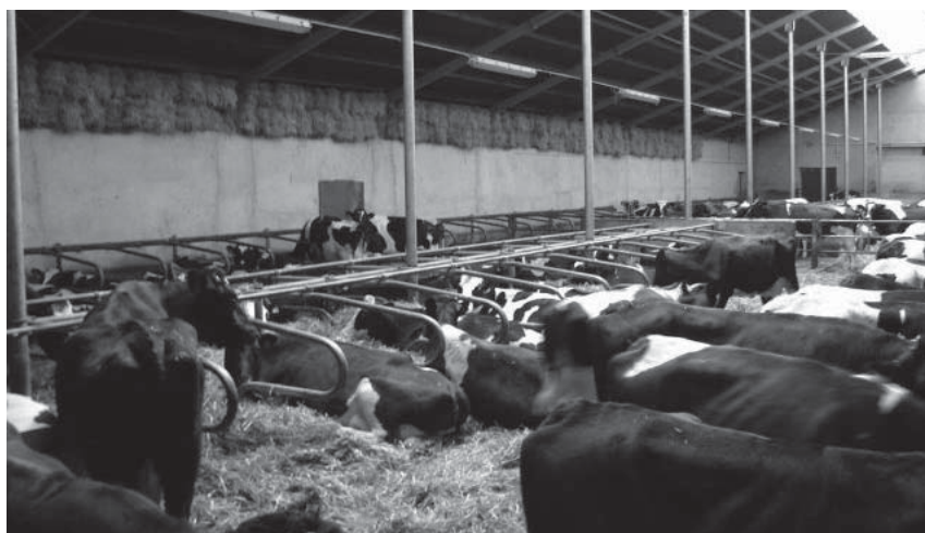
Fotografia 5. Wloty powietrza zasłonięte balotami ze słomy – brak wymiany powietrza
